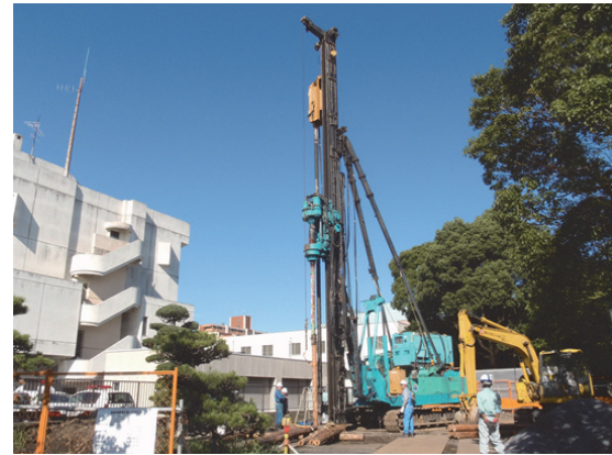
大型機を用いた施工(集会所)
