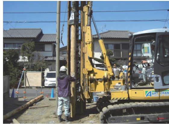
小型機を用いた住宅地における施工(戸建て住宅)
